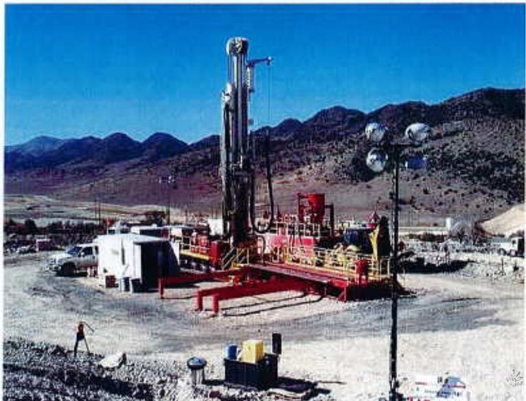
Este proyecto requiere la construcción continua, incluyendo trabajo de noche, para asegurar la estabilidad de la perforación para cada pozo.
